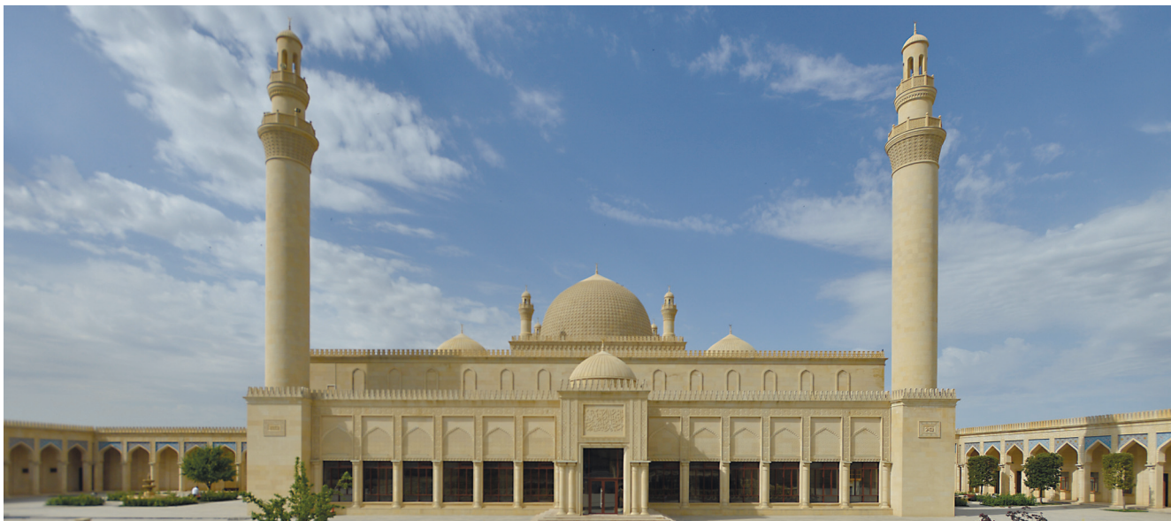
مسجد الجمعة في شامخي وهو أقدم المساجد في القوقاز. القرن الثامن. الصورة بعد الترميم الحديث
