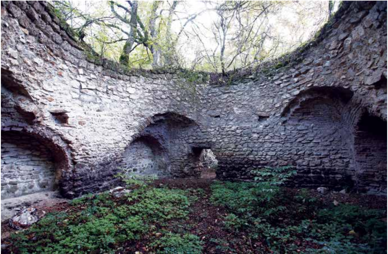
Eines der erhaltenen Bauwerke der Urek-Festung
