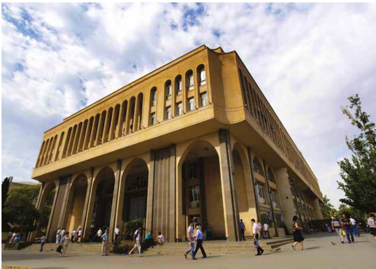
Здание станции метро «Элмляр академиясы» в Баку (на втором этаже административные помещения)
